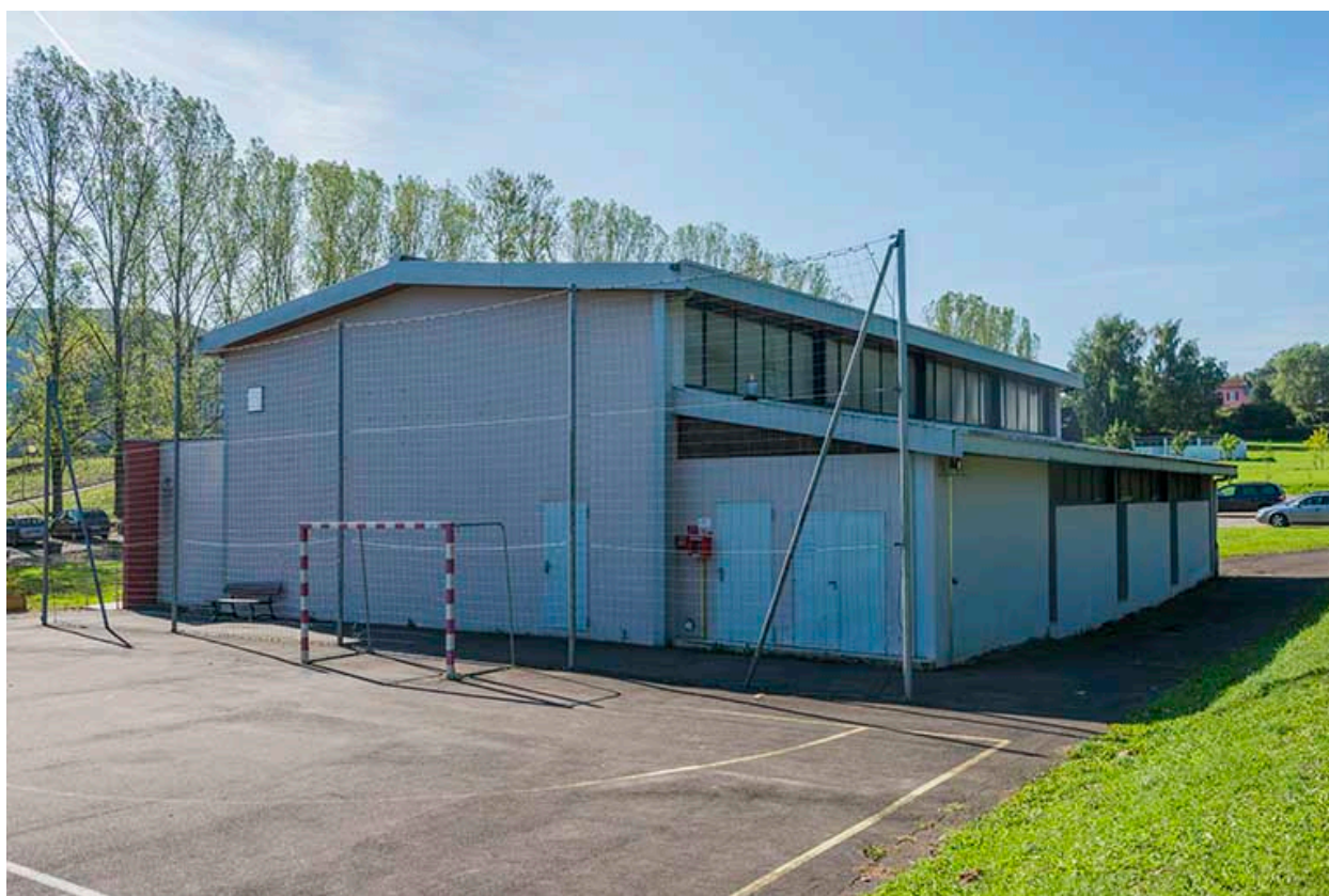
Angle nord et pignon nord-est du gymnase
