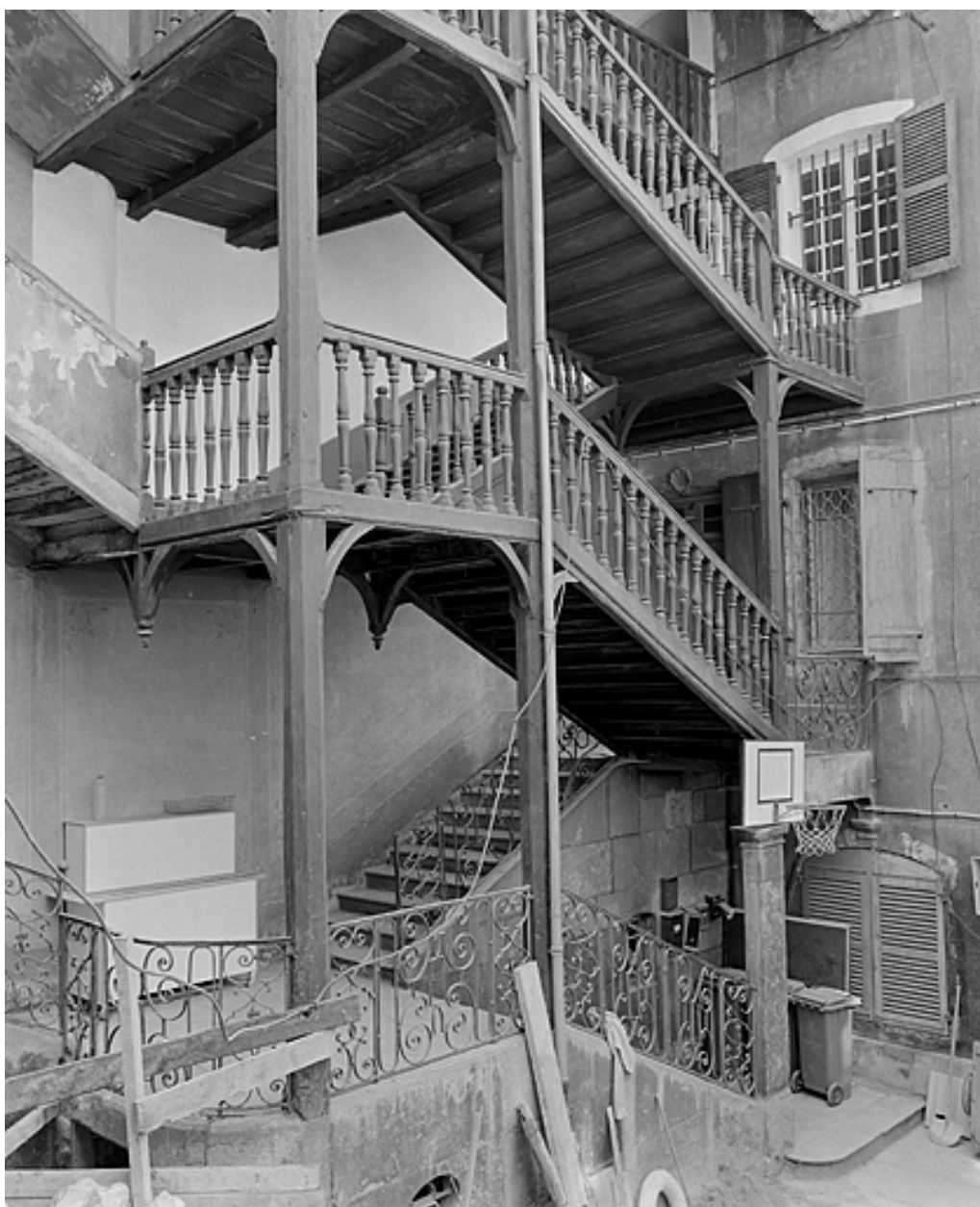
L'escalier s'ouvrant sur la cour.
