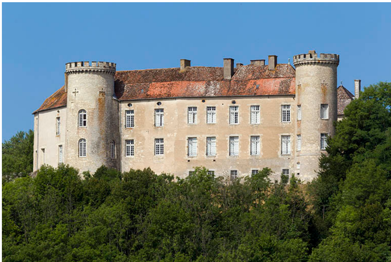
Vue générale de la façade est.
