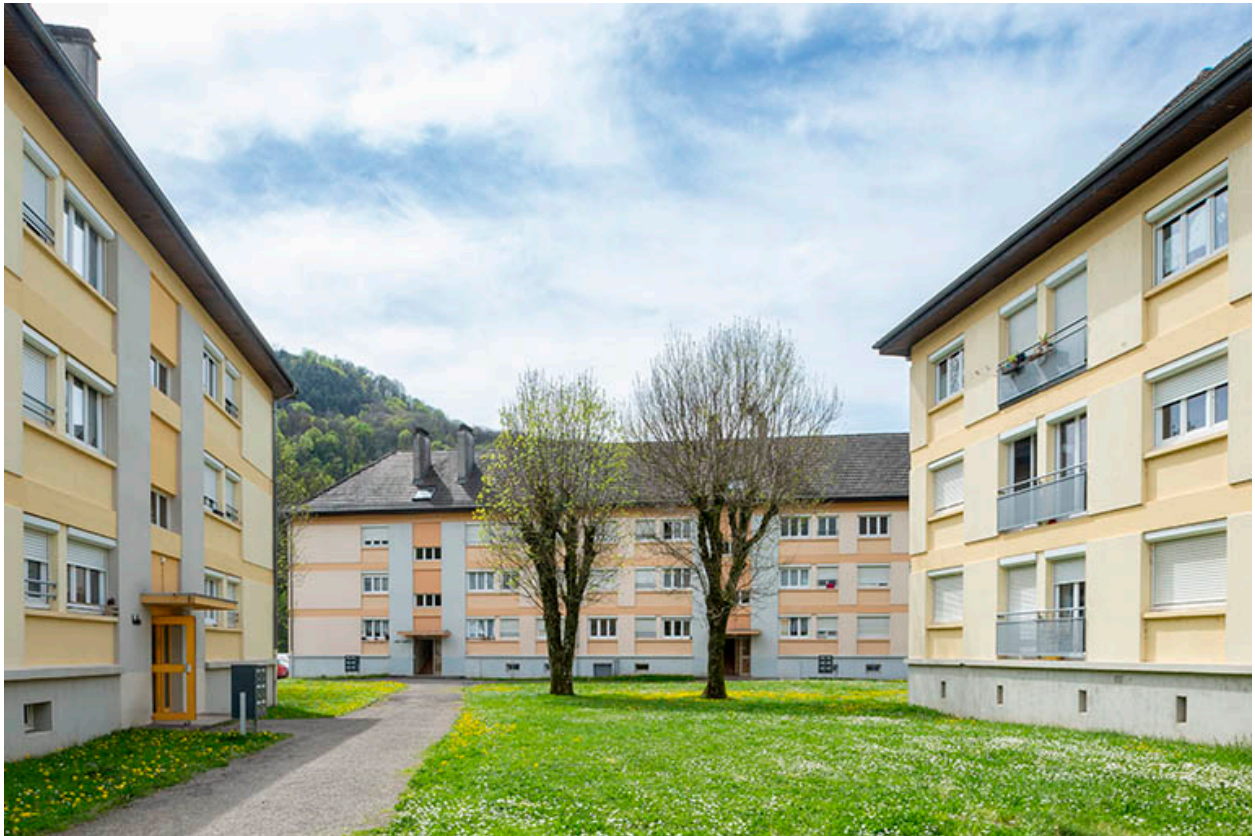
Vue du bâtiment Saint-André, entre celui de Belin et Max Claudet.
