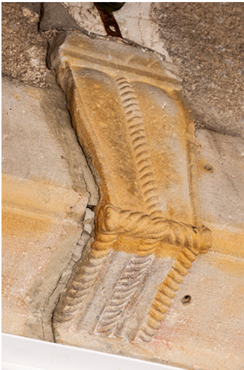
détail de la porte d'entrée, façade ouest.
