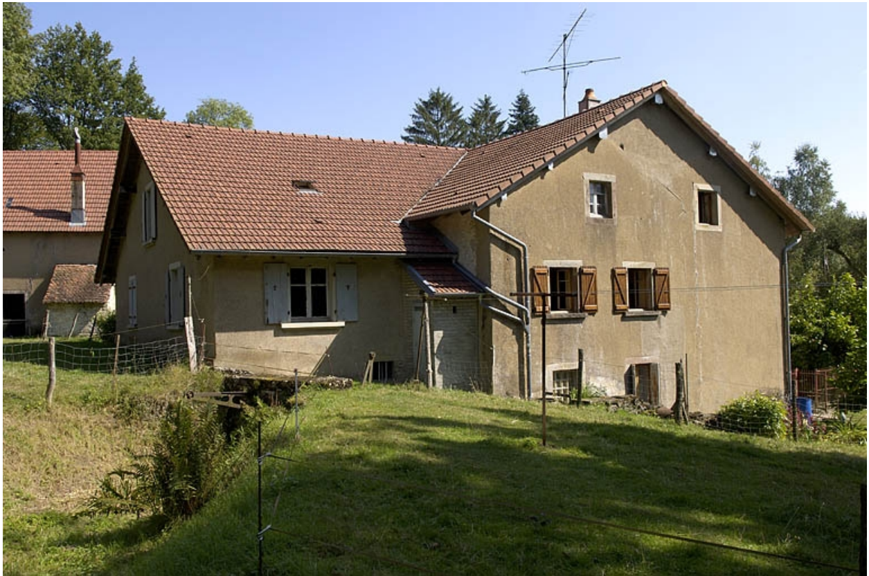
Façade ouest du moulin.
