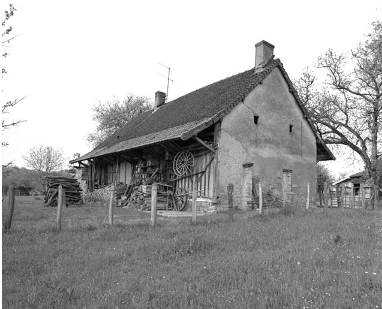
Façades postérieure et latérale gauche.
