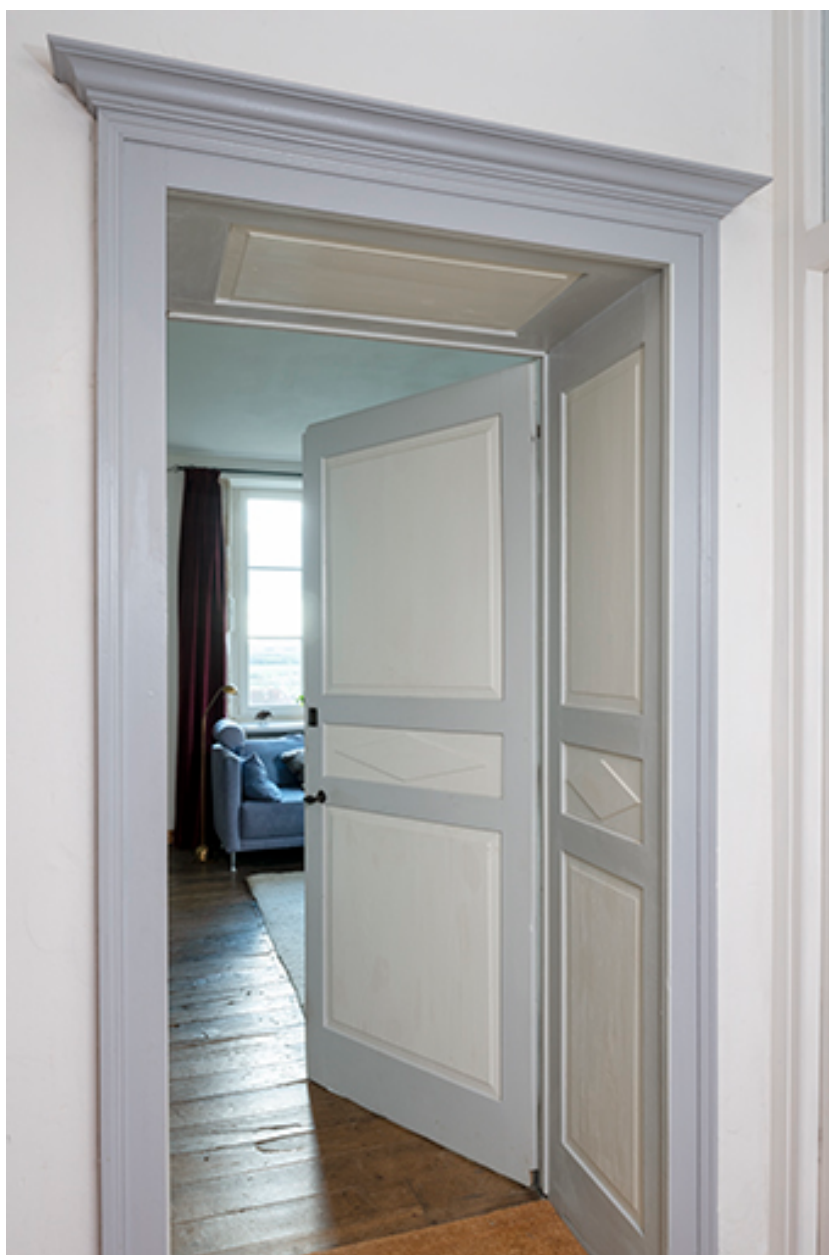
Rez-de-chaussée : détail de baie et menuiserie.
