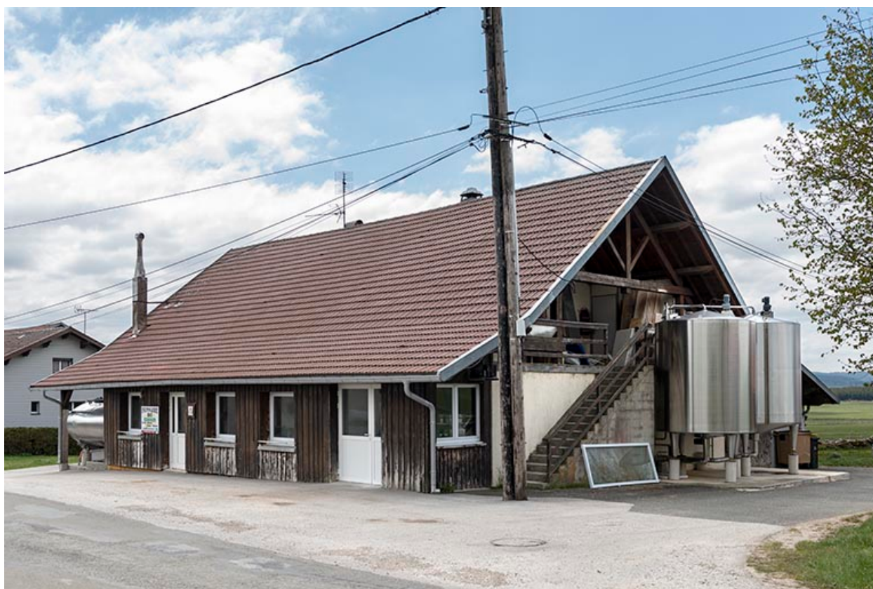
Façades postérieure et latérale droite.
