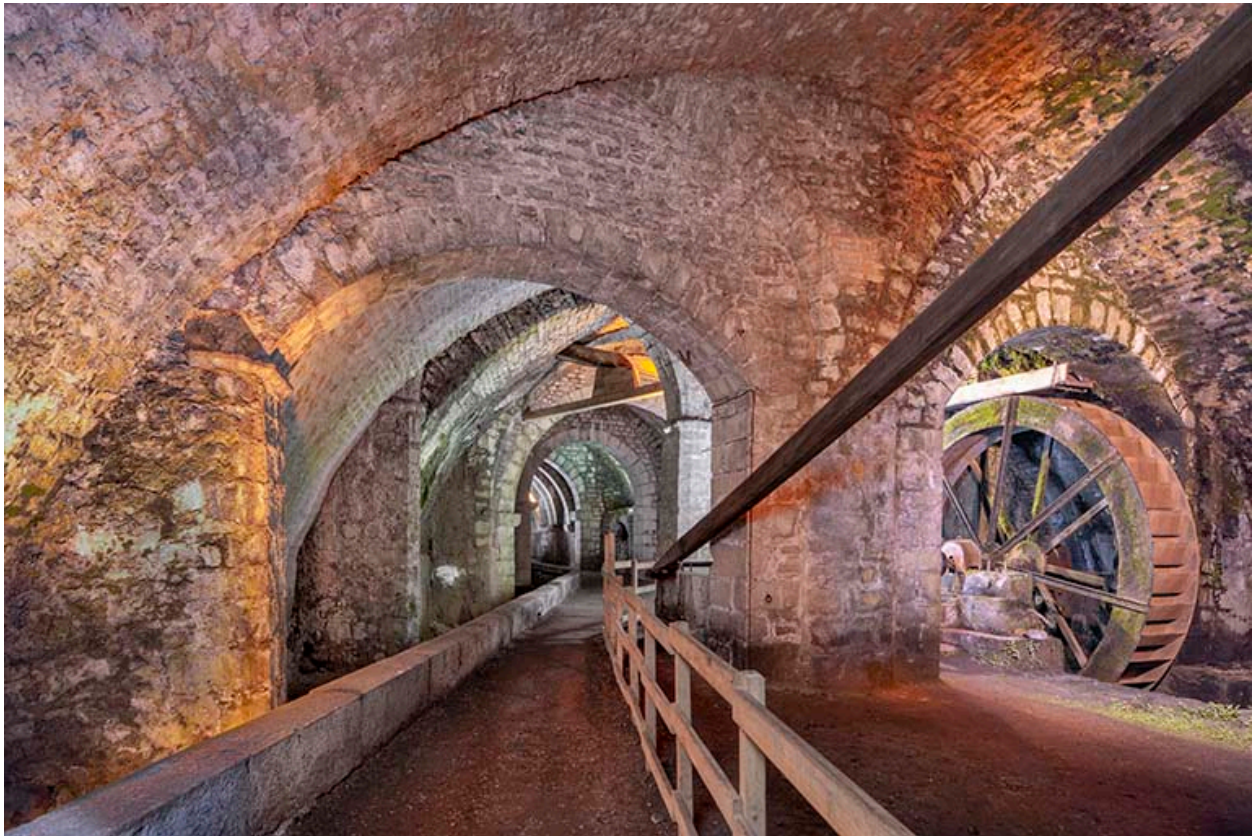
Extrémité nord du puits d'Amont et mécanisme hydraulique.
