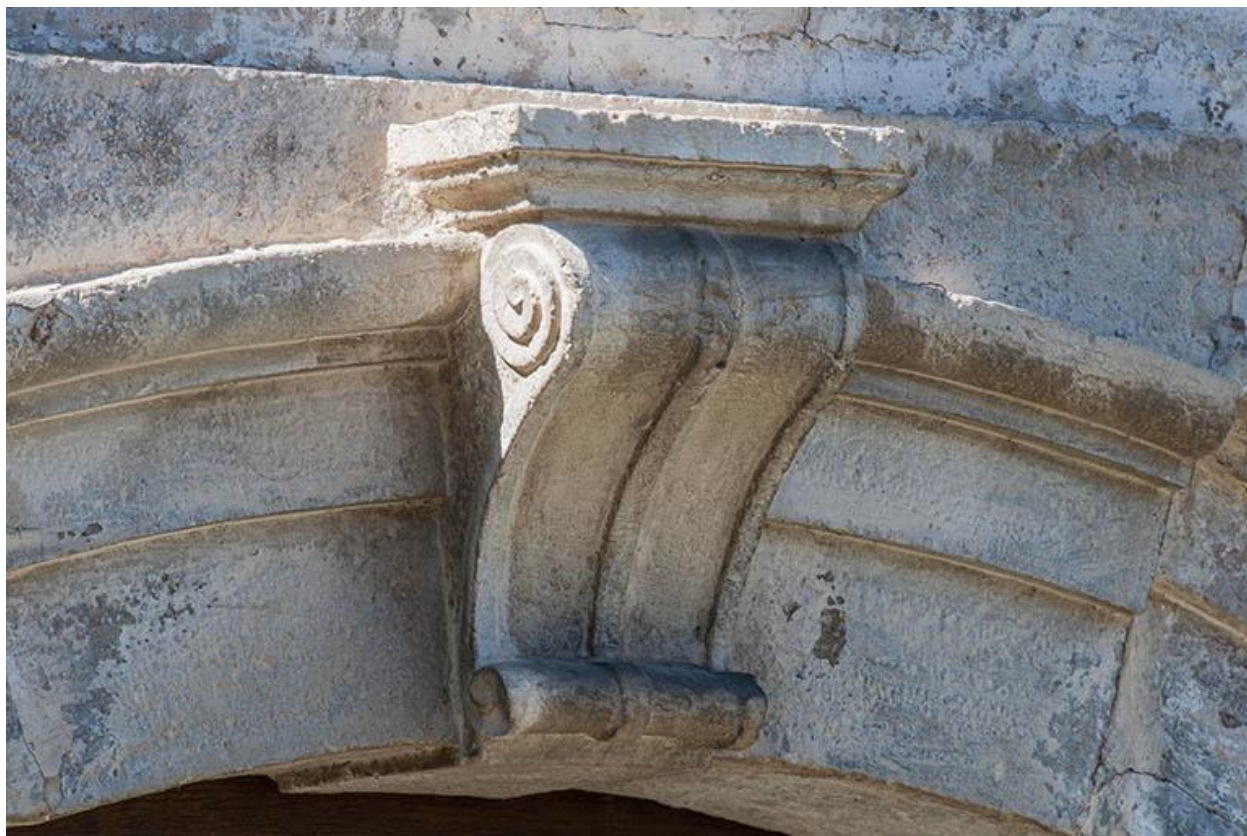
Détail de la porte
