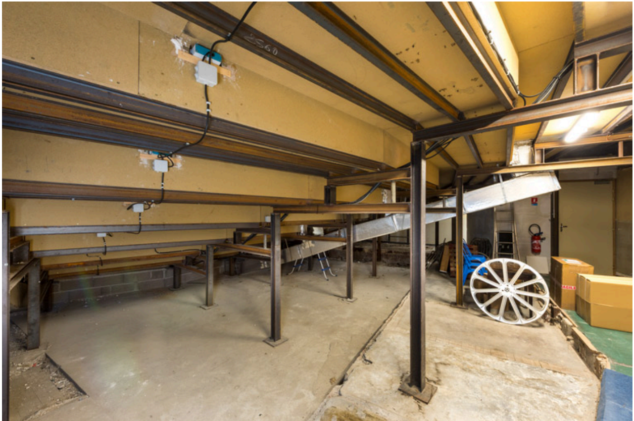
Espace sous les gradins de la salle.
