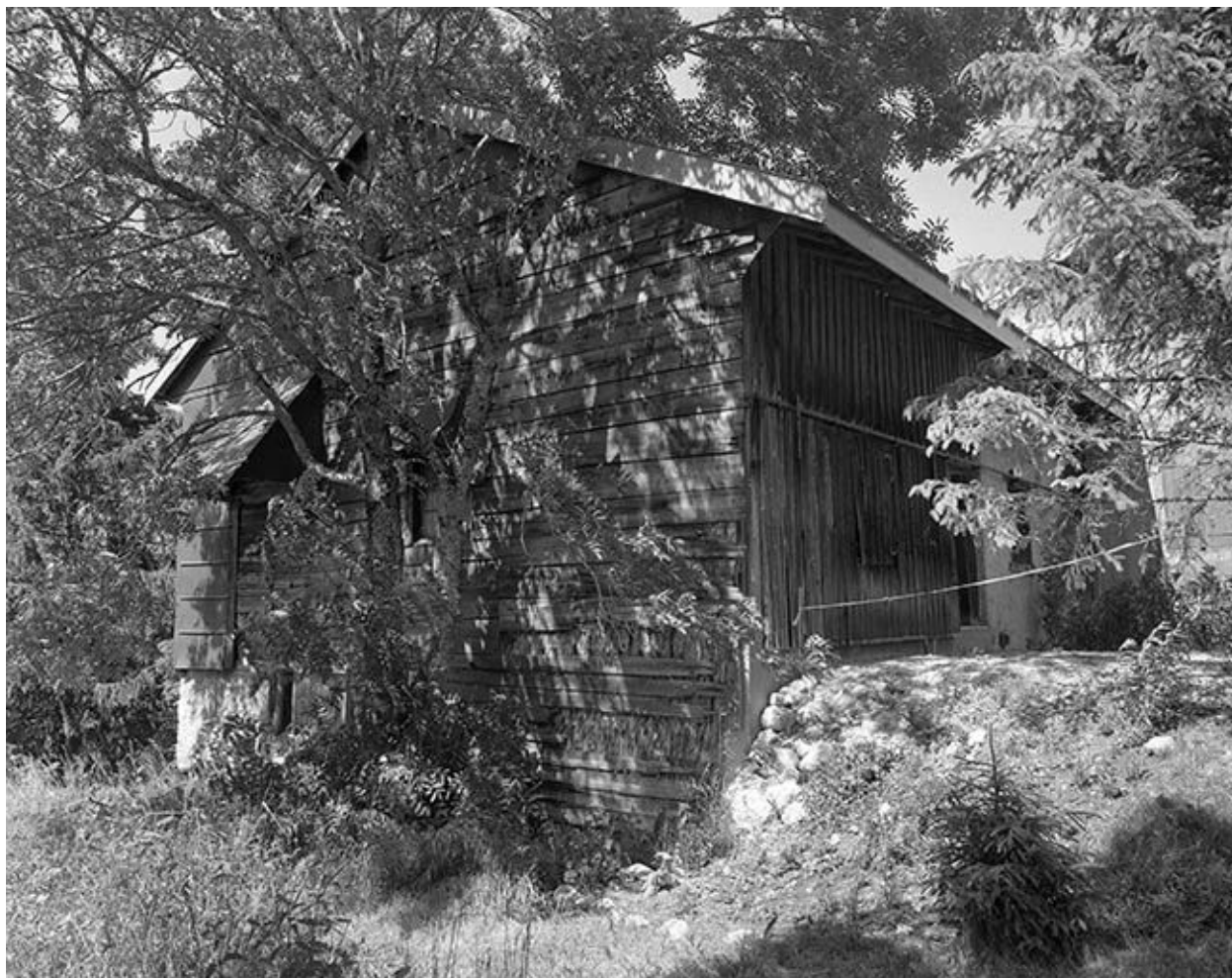
Le bâtiment abritant la scierie.
