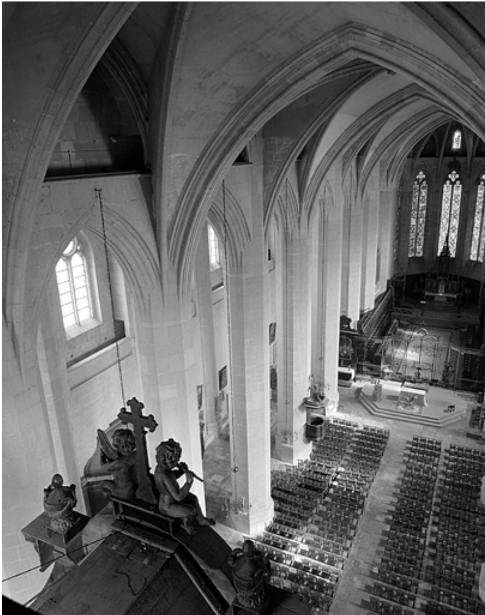
Elévation nord de la nef depuis la coursière haute.
