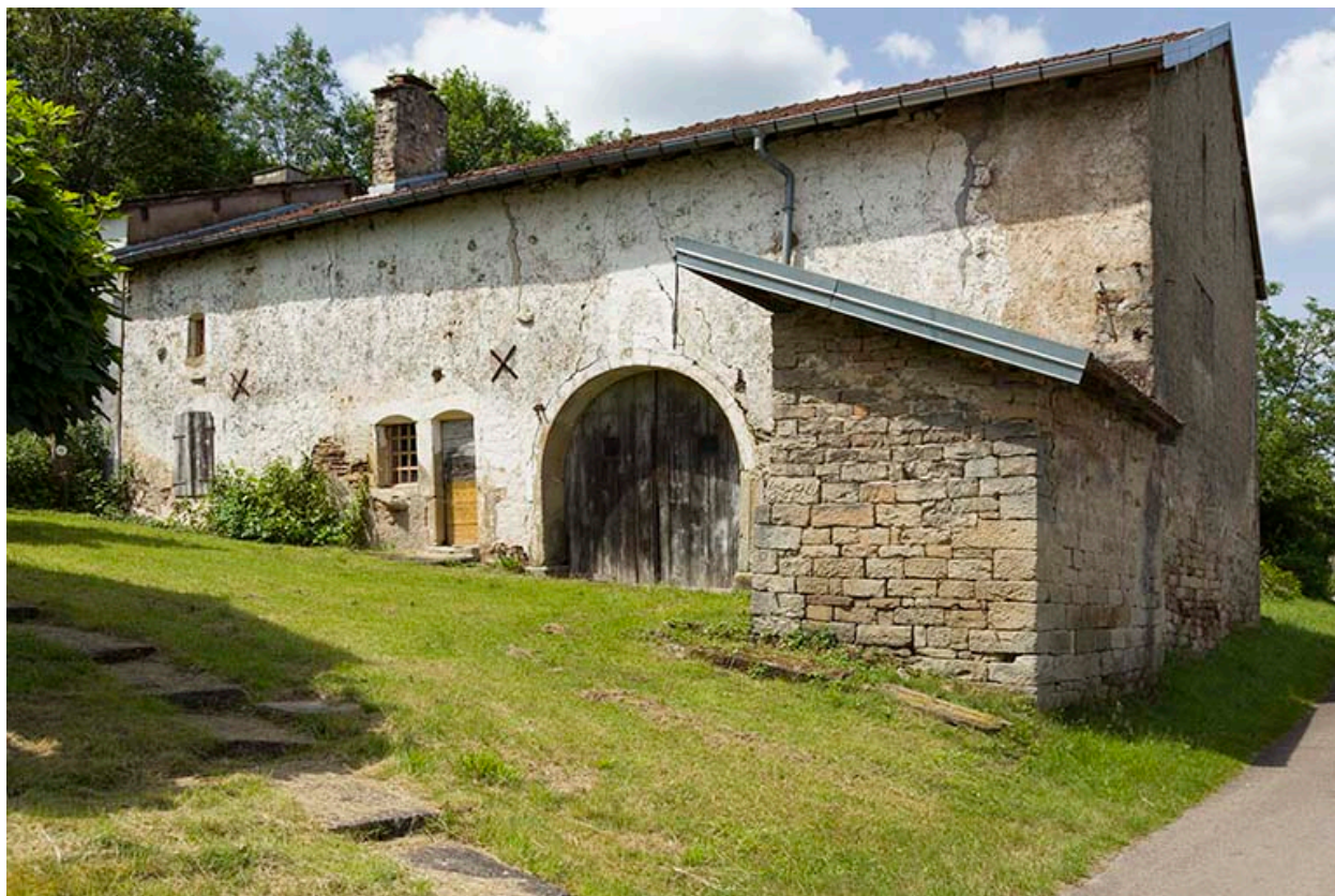
Ferme, perpendiculaire à la rue Principale (au 15.)
