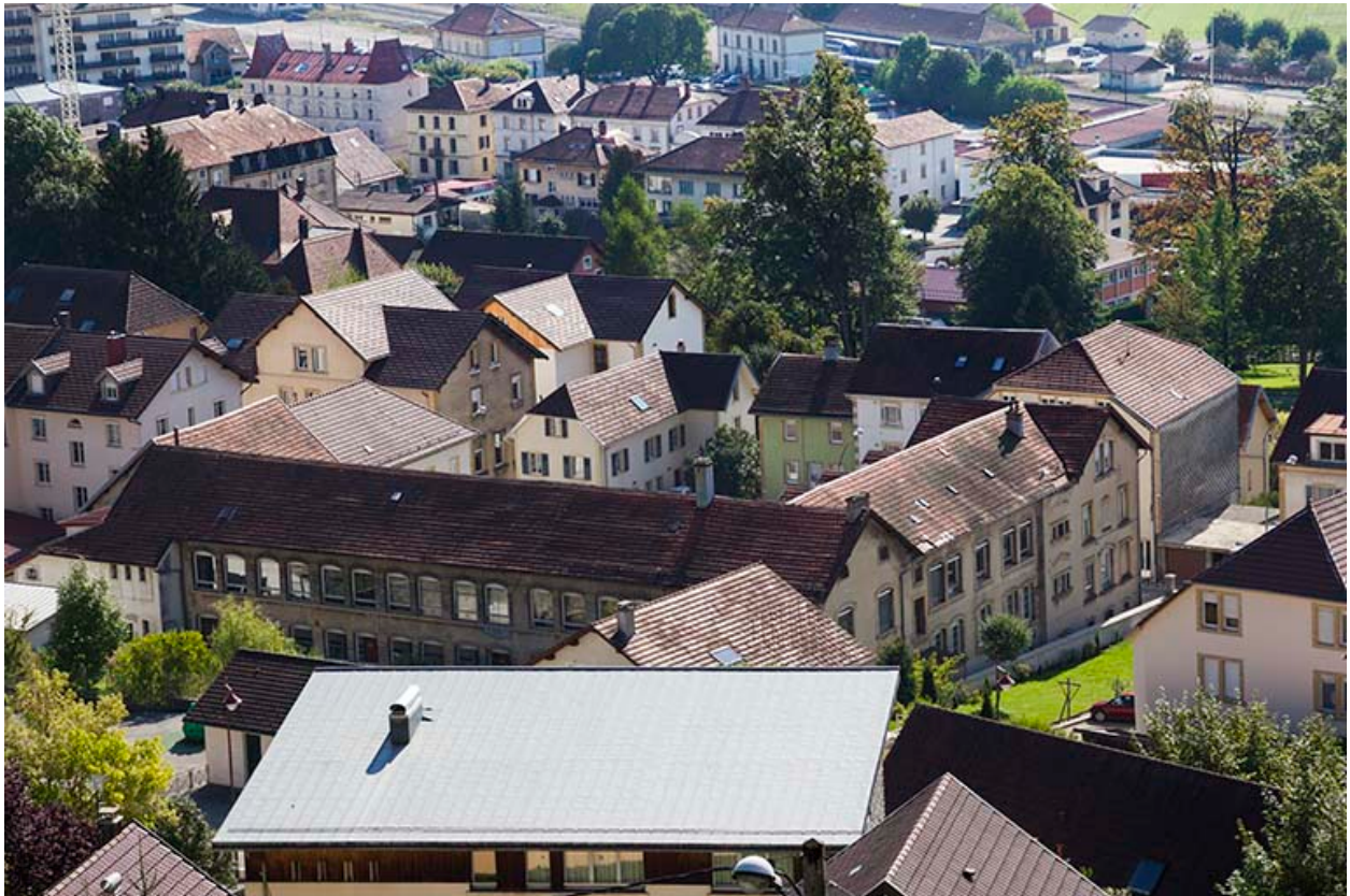
Vue d'ensemble plongeante, depuis le nord-ouest.
