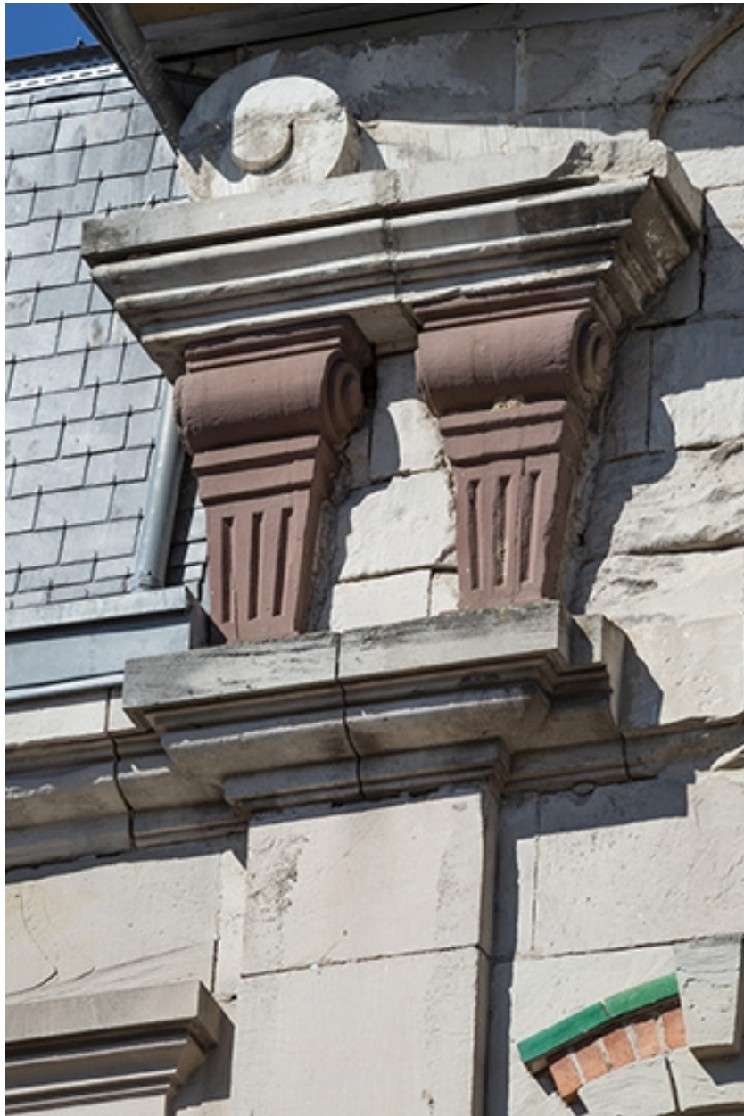
Façade sur la rue de Grammont, partie centrale, portail, détail : pilastres en gaine jumelés surmontés d'une volute.
