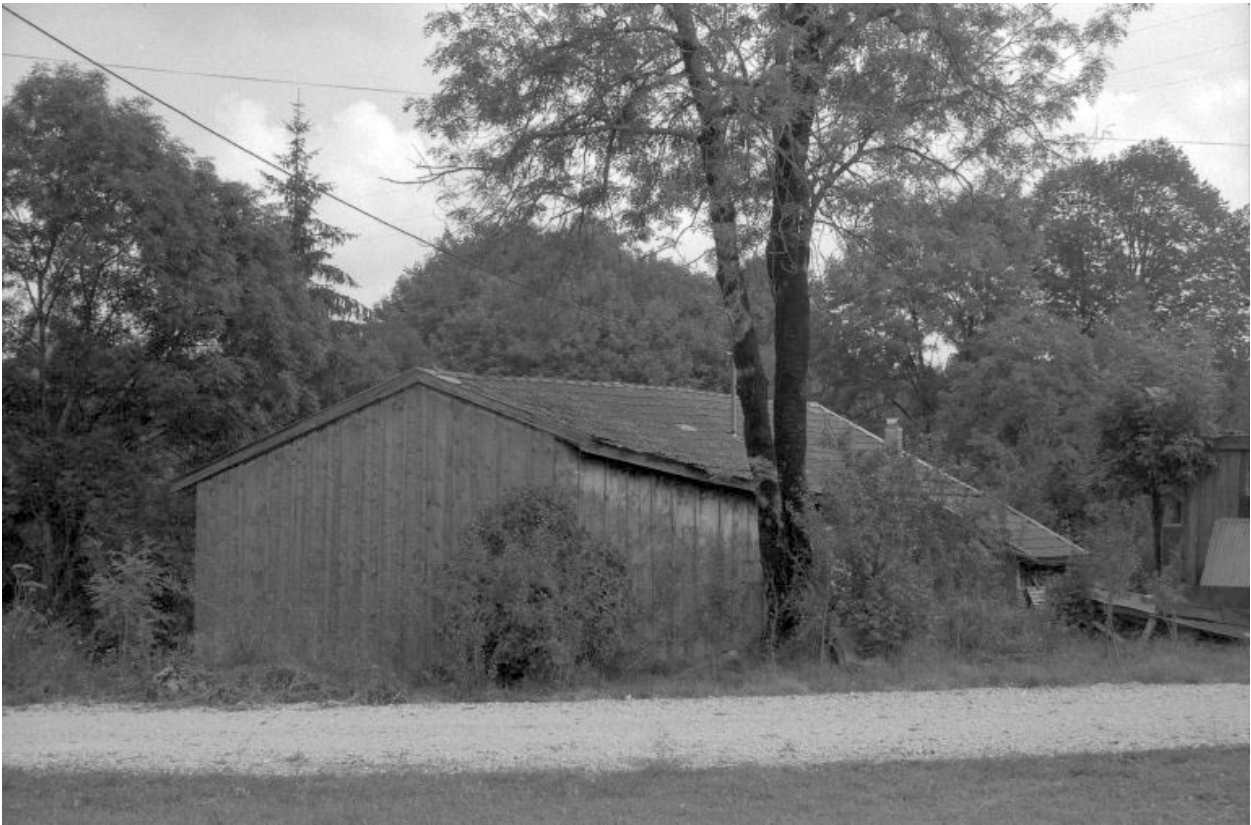
Façades antérieure et latérale droite.
