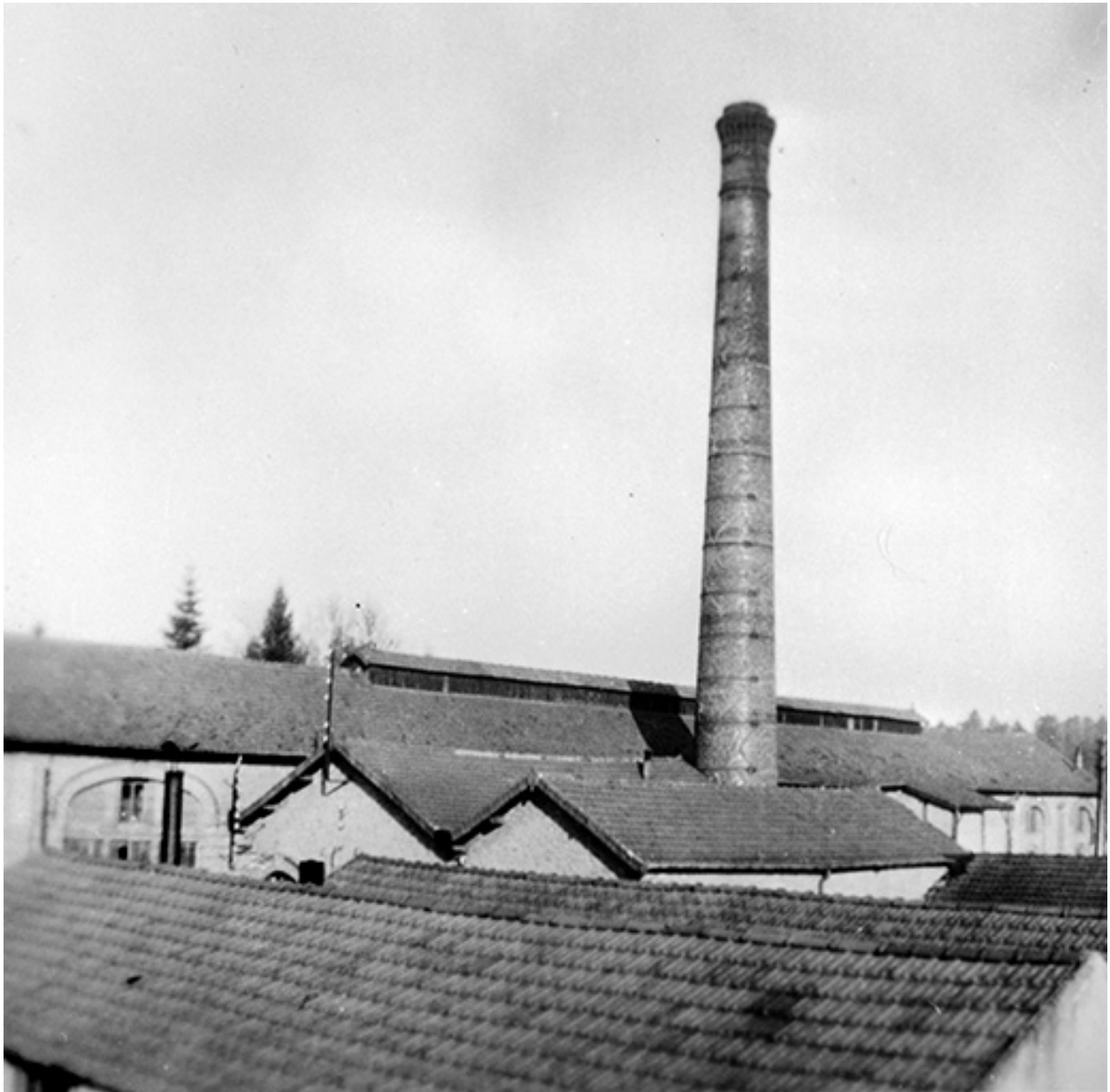
Ateliers et cheminée vus de l'est.
