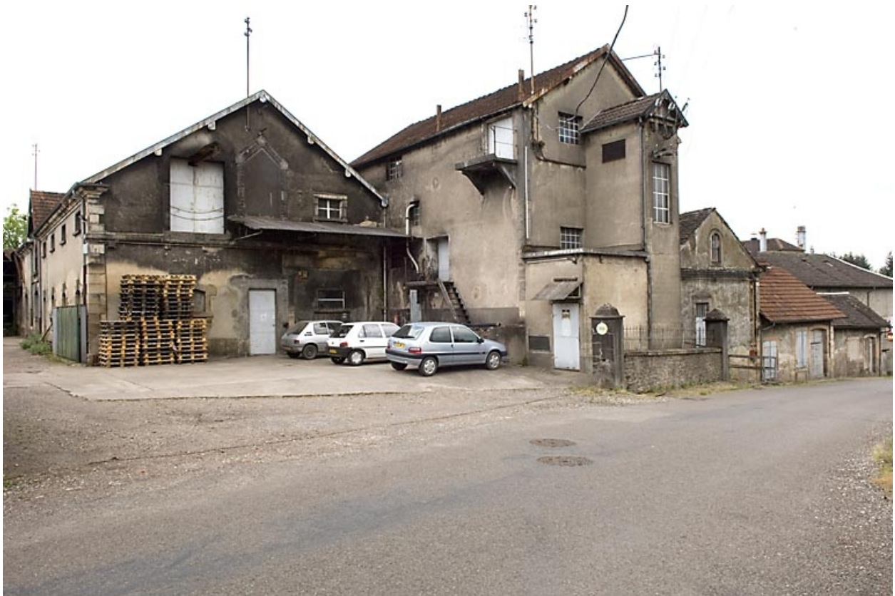
Ancienne écurie et cuverie. Vue depuis l'est.
