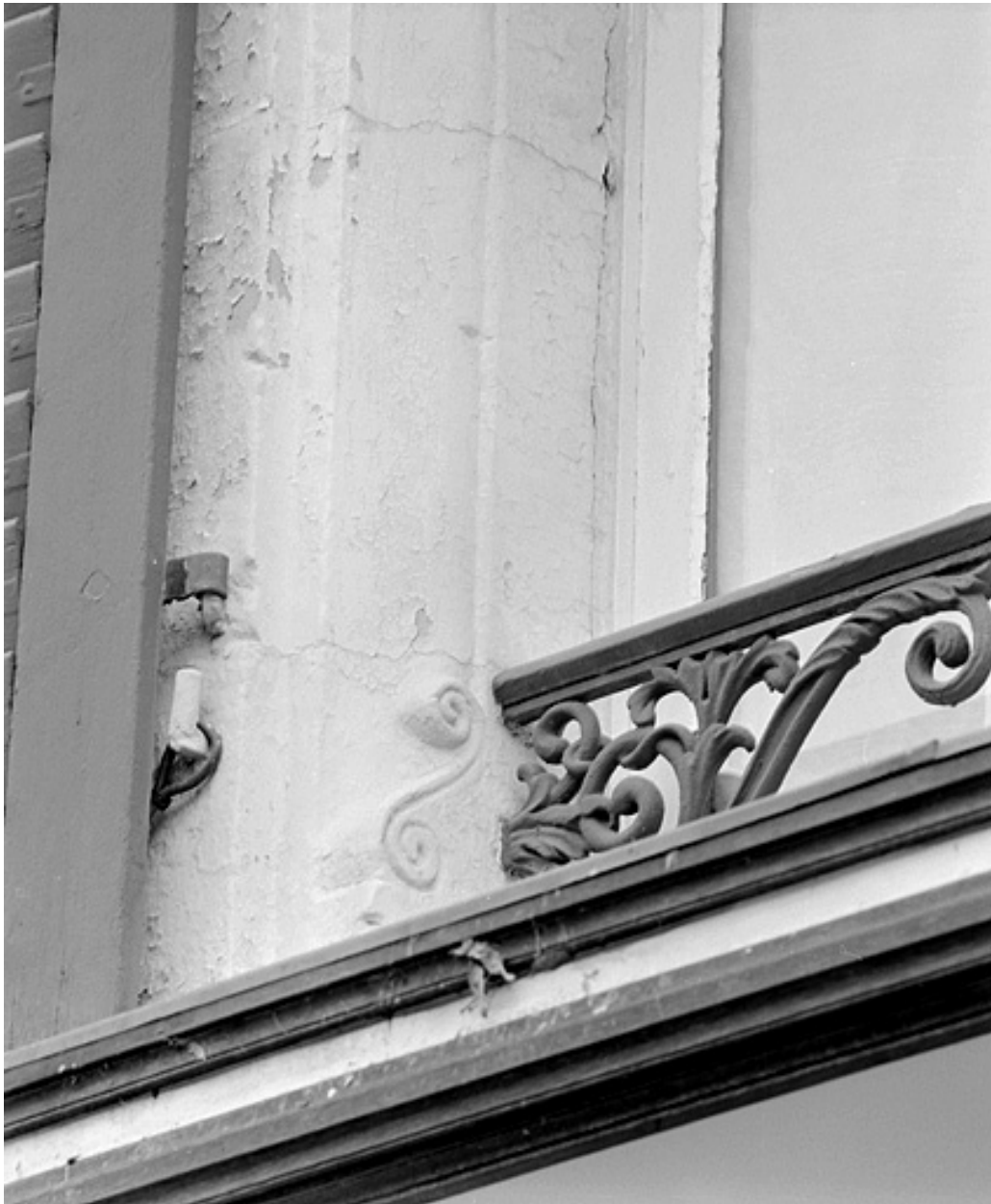
Maison 27, place Denfert-Rochereau. Détail d'une fenêtre du premier étage. Deuxième moitié 16e siècle.
