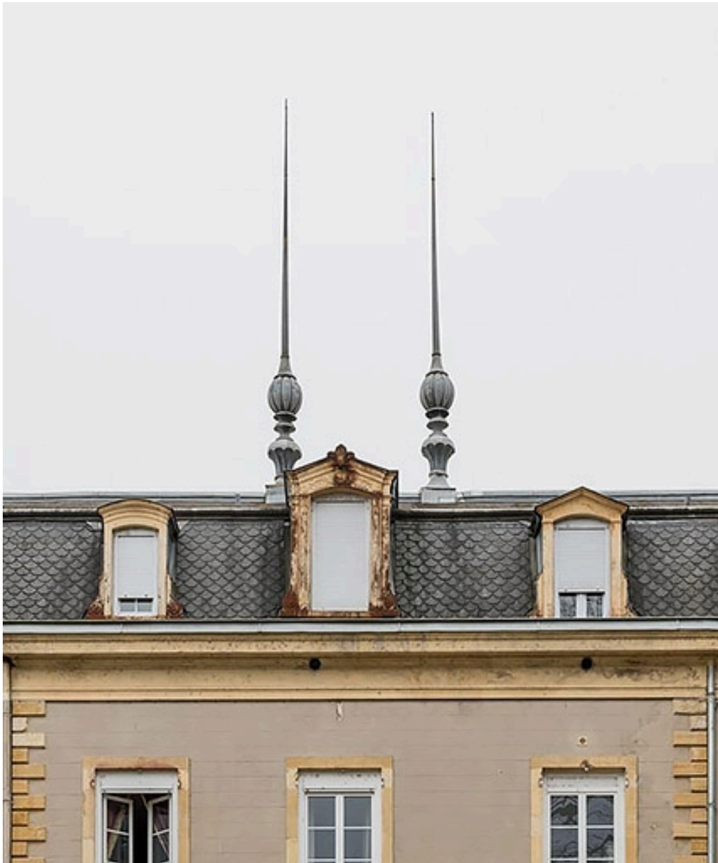
Aile nord, épis de faîtage.
