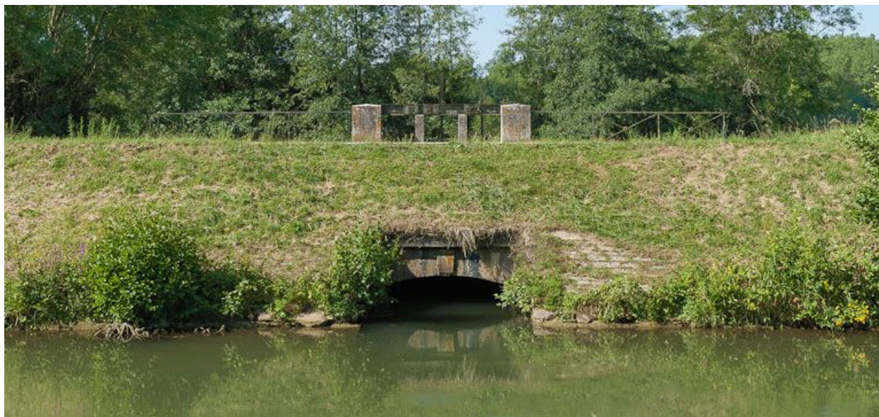
Sortie du déversoir.
