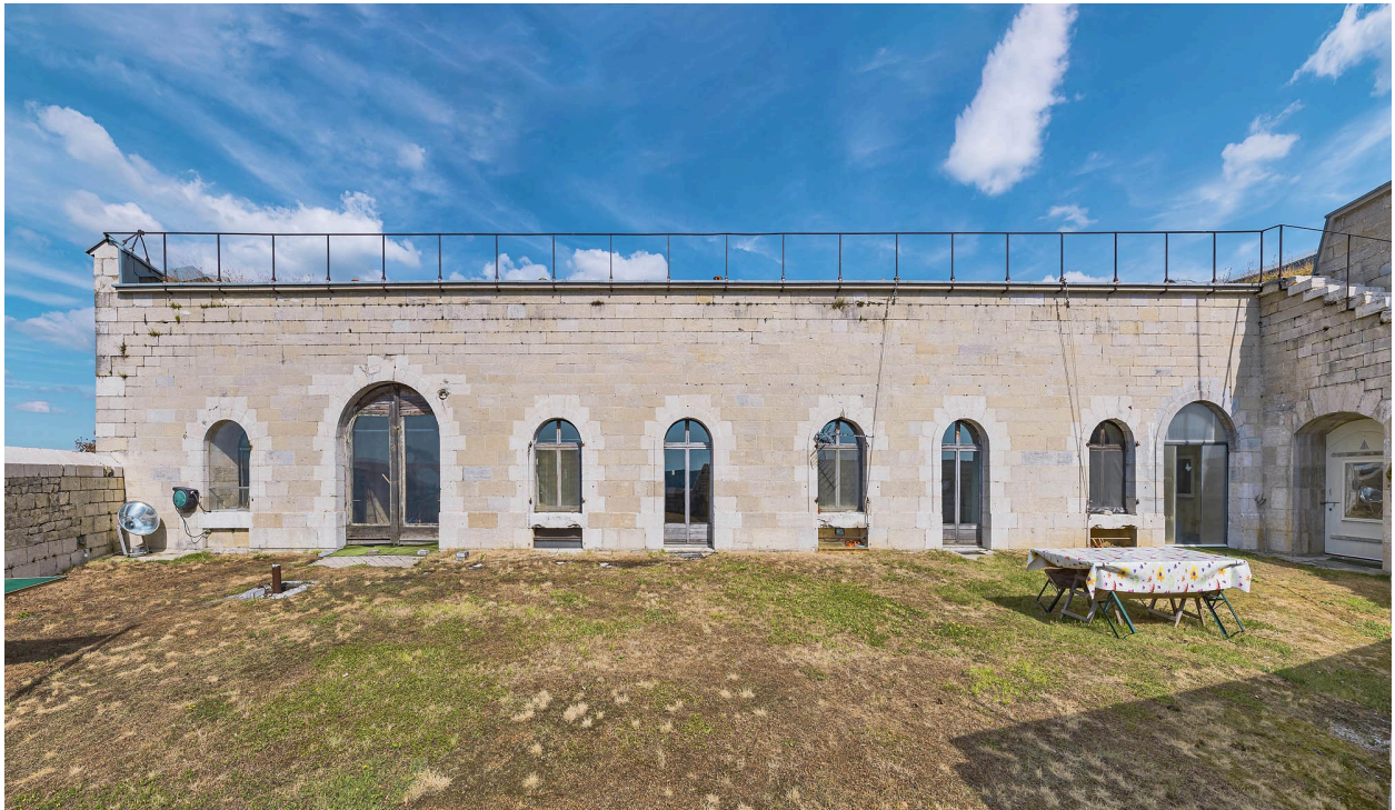
Vue générale de la façade postérieure.
