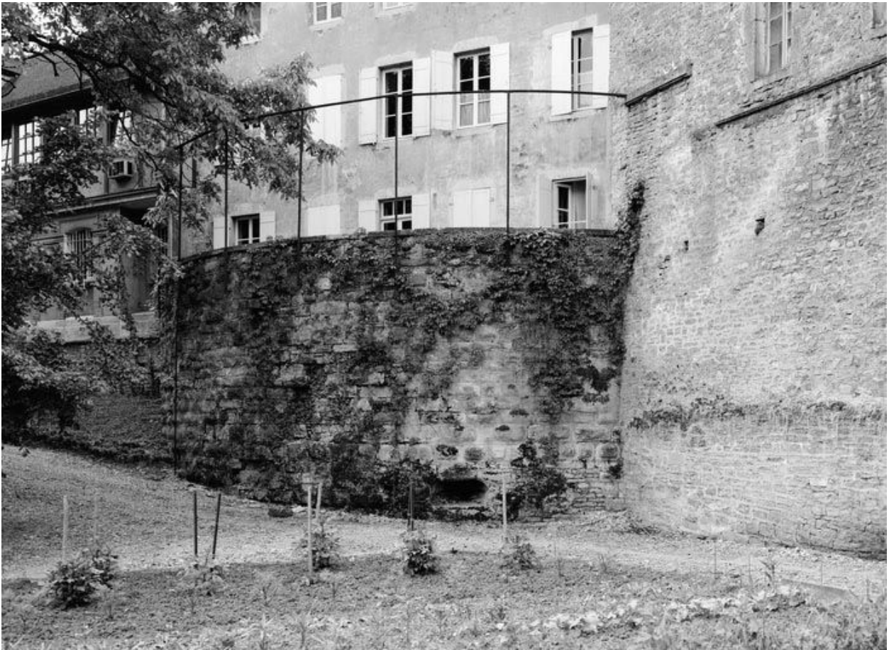
Vestiges de la tour nord-ouest depuis le fossé (1988).
