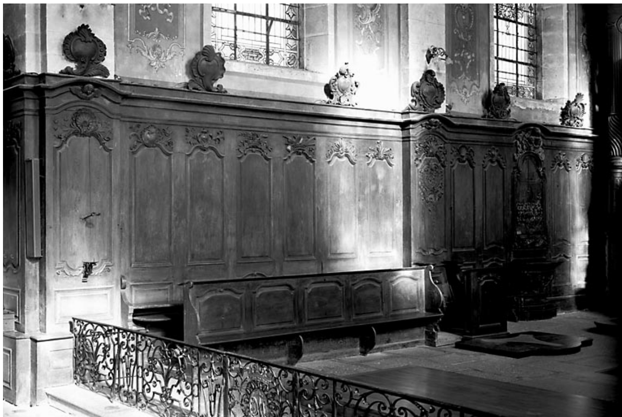
Vue d'ensemble du côté gauche du chœur.
