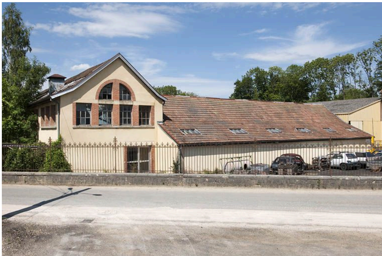
Atelier de fabrication (emboutissage, décolletage).
