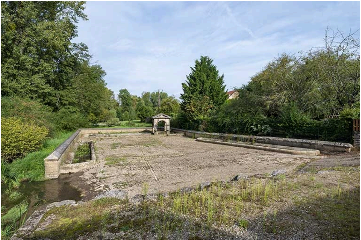
Fontaine, lavoir et abreuvoirs construits en 1834. Vue d'ensemble.
