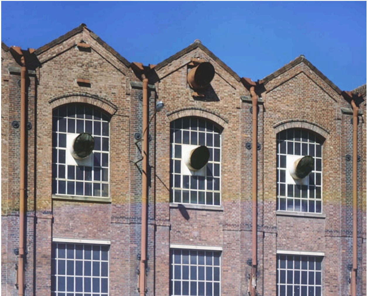
Détail de la façade est de l'ancien atelier des grandes dynamos.
