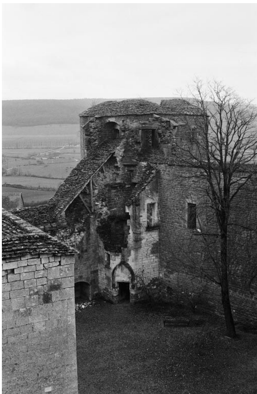
Enceinte : tour d'angle avec tourelle. Vue générale intérieure (photo prise en 1969).
