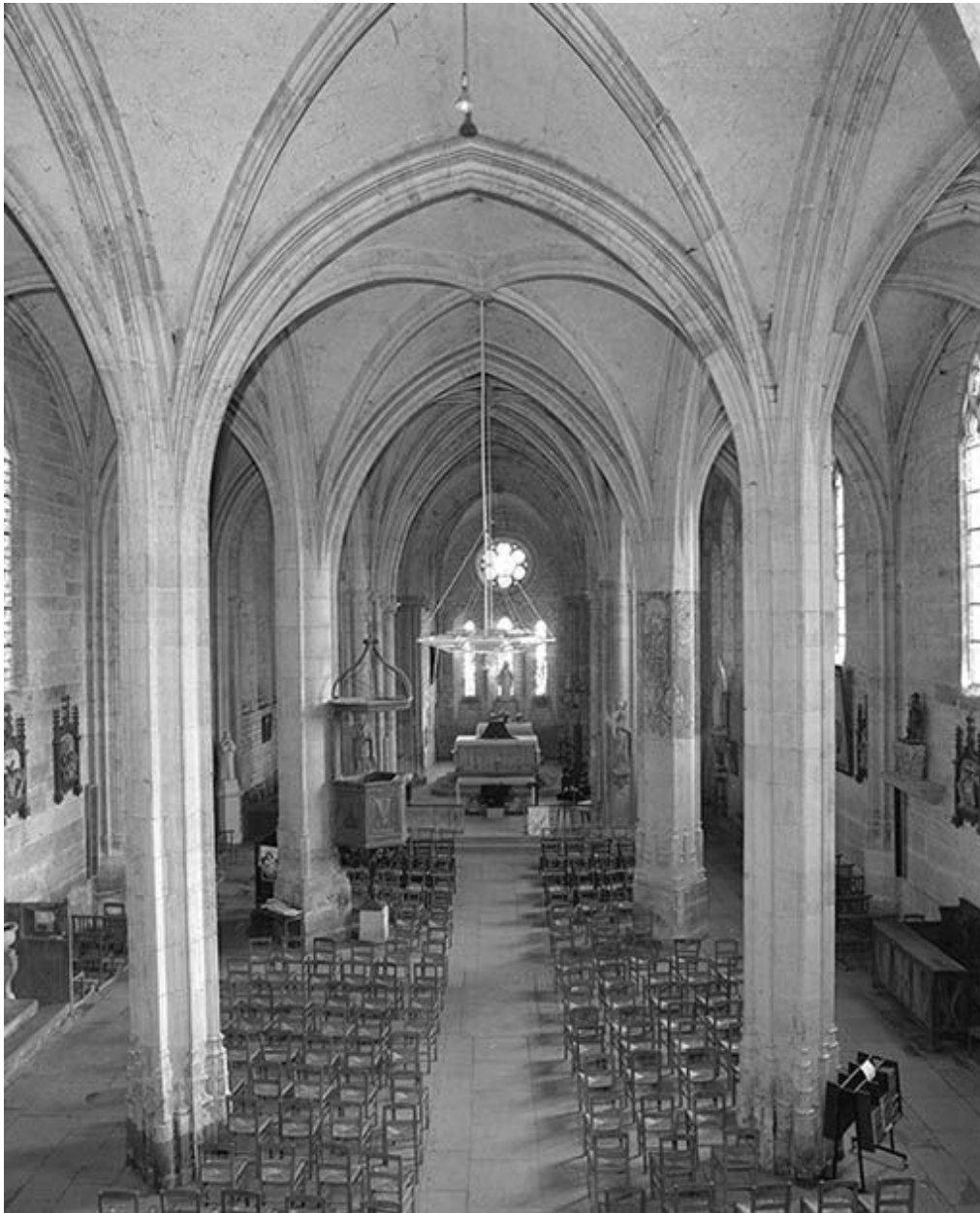
Vue intérieure prise de la tribune.
