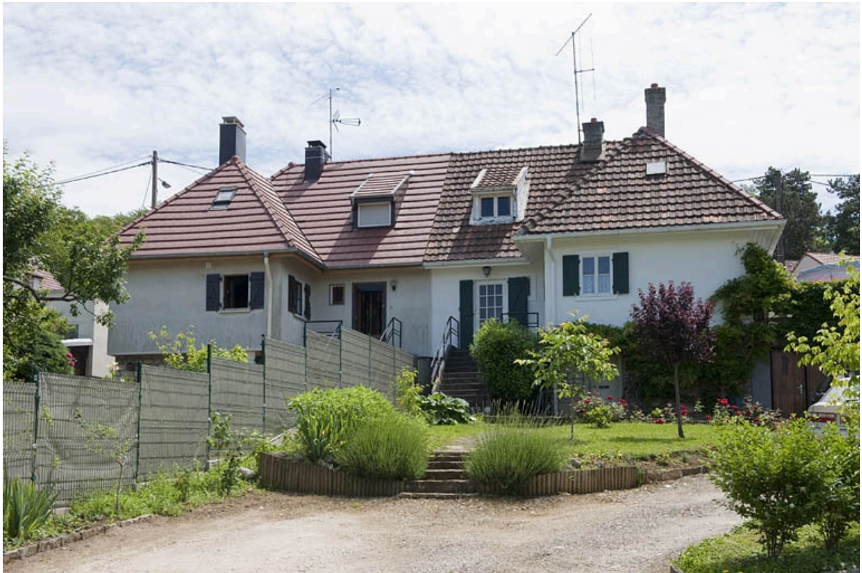
Maisons jumelles rue Raoul Delattre. Façades ouest.
