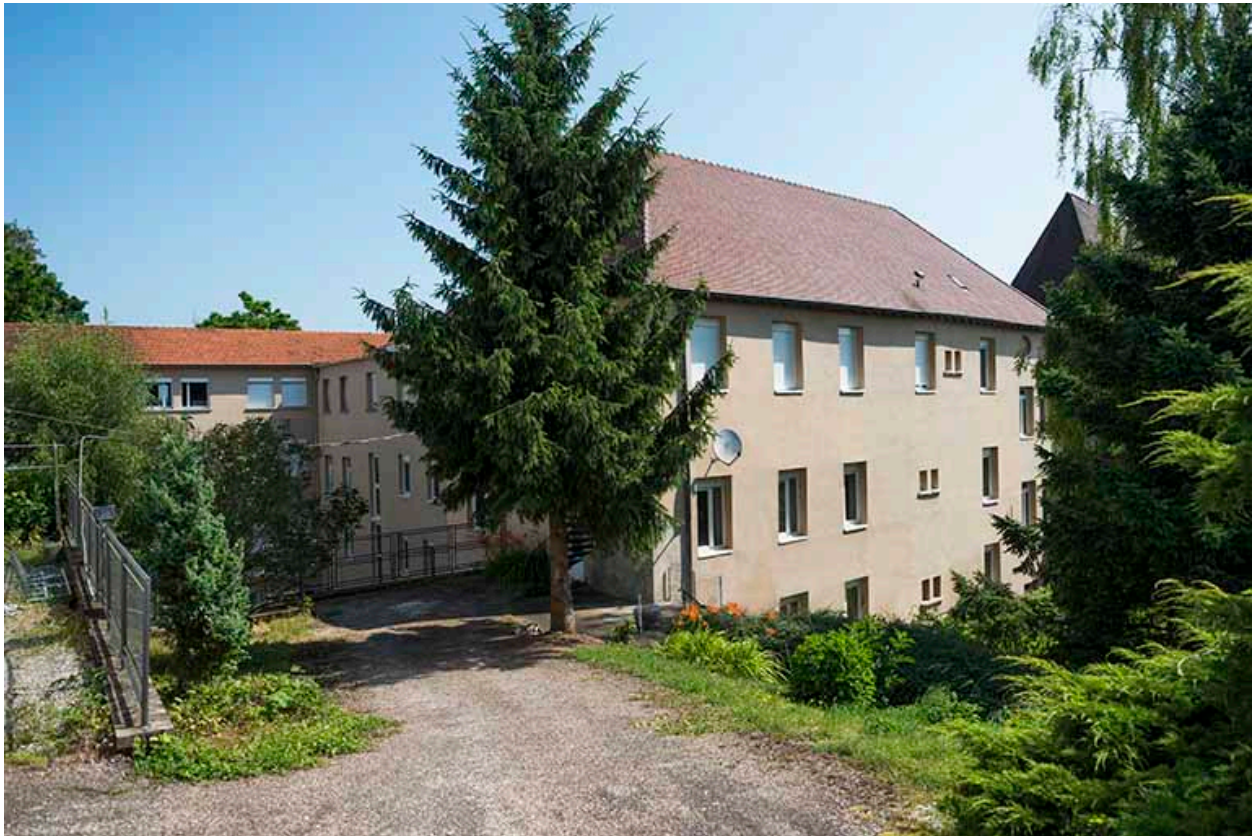
Angle sud-ouest du bâtiment d'administration.
