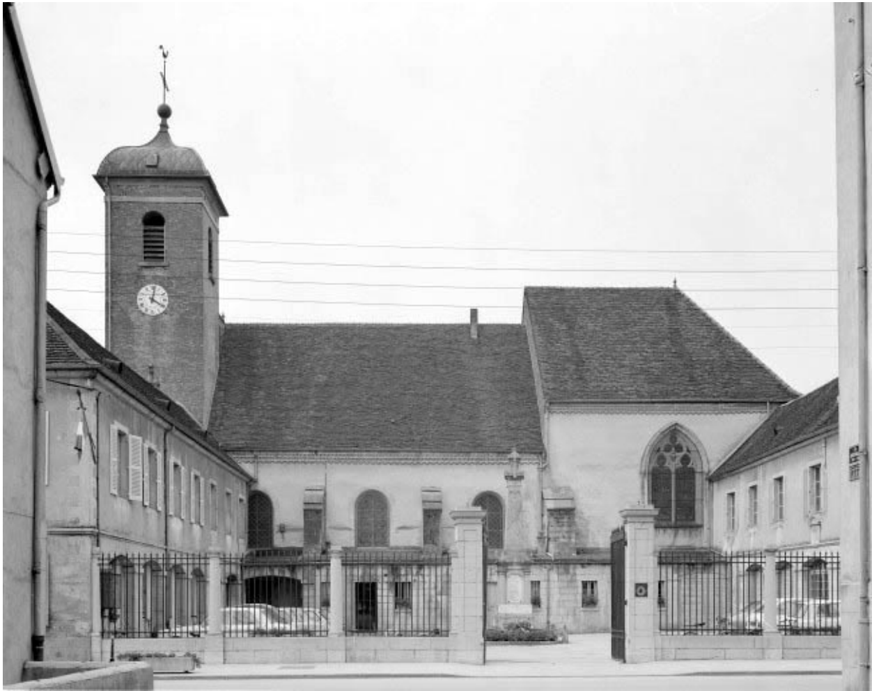
Façade latérale droite.
