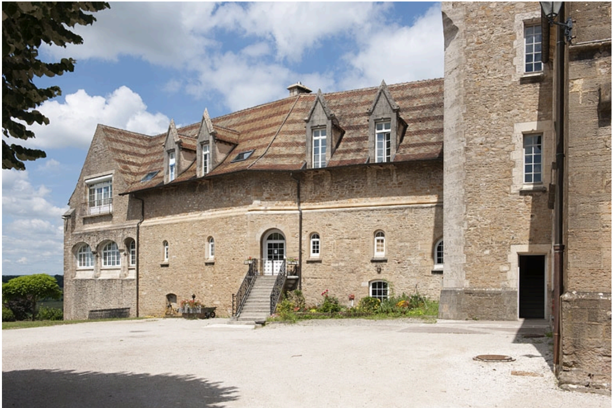
Bâtiment (C), vue depuis la cour.
