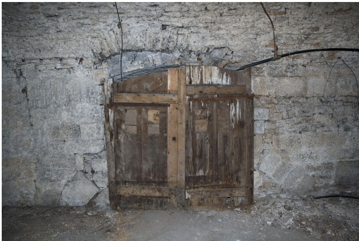
Logis principal, sous-sol : cave C.
