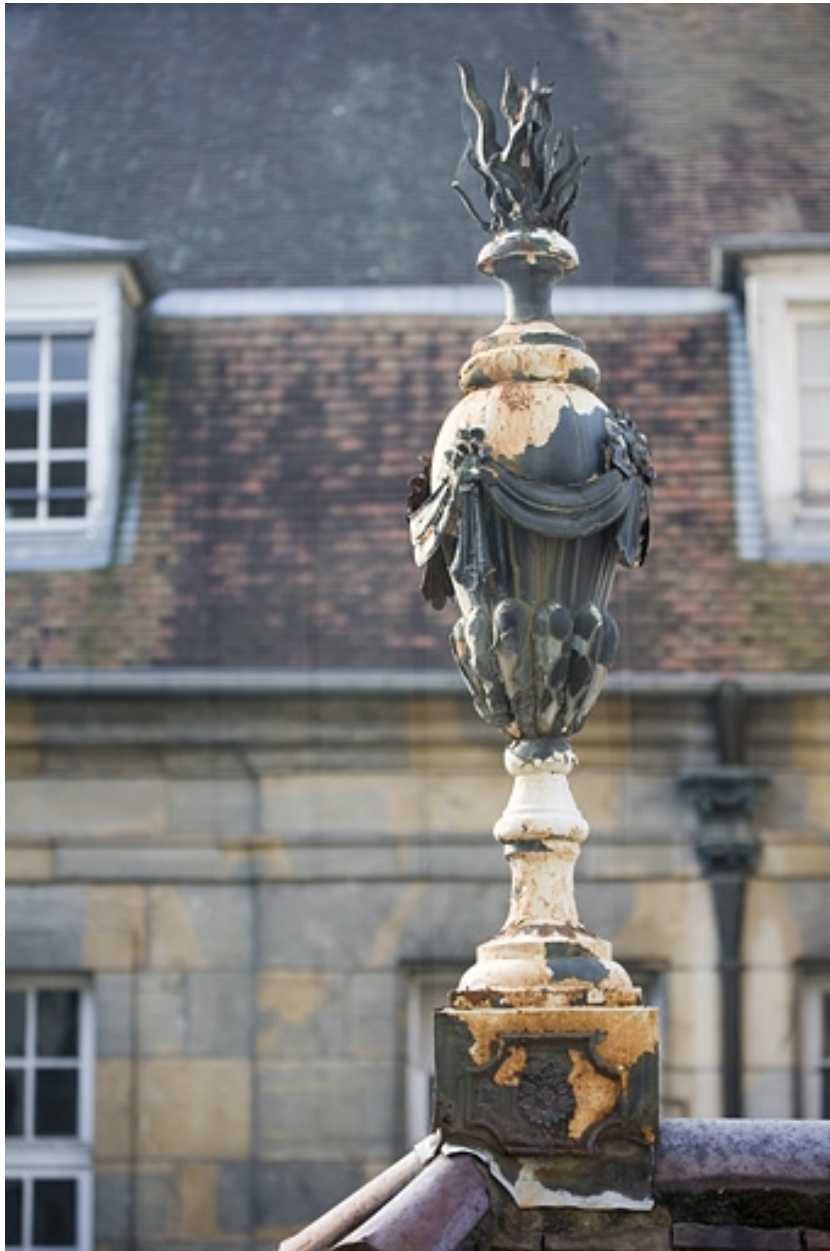
Détail d'un épi de faîtage sur le bâtiment droit des communs.
