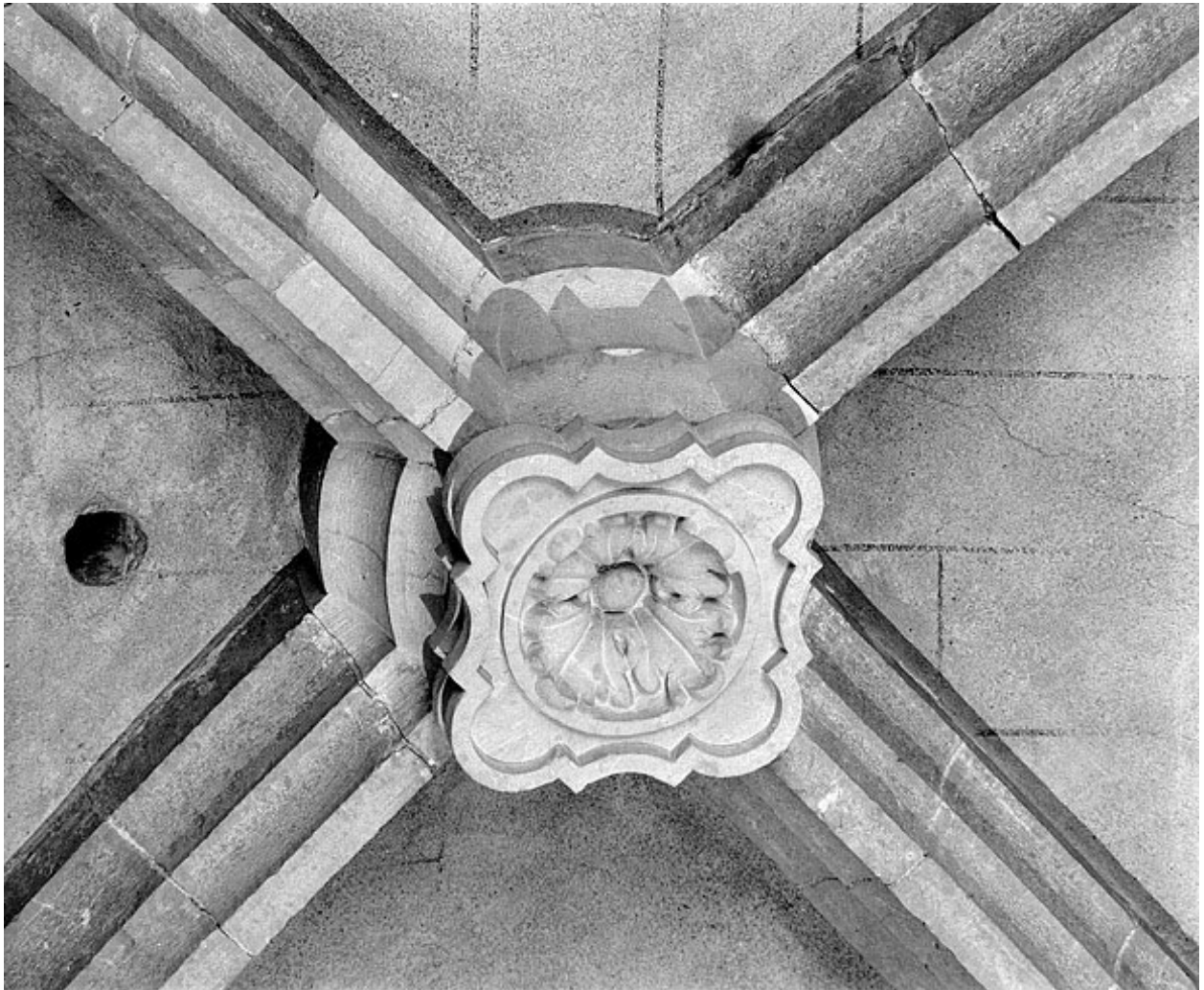
Clef de voûte de la quatrième travée du collatéral nord.
