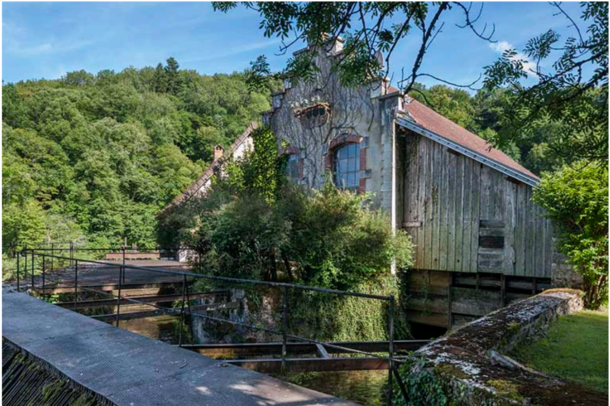
Prise d'eau, centrale hydroélectrique et bâtiment d'eau.
