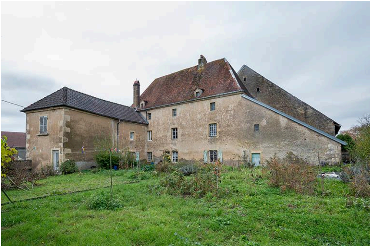
Ferme 13 Grande rue, vue depuis la voie ferrée.
