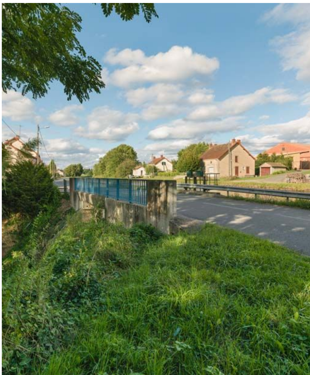
Vue du déversoir.
