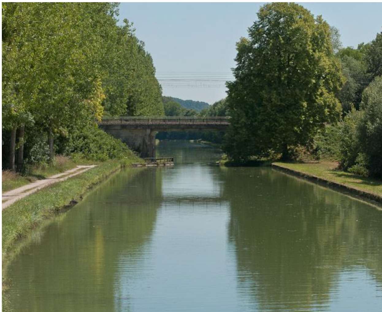
Vue du pont.
