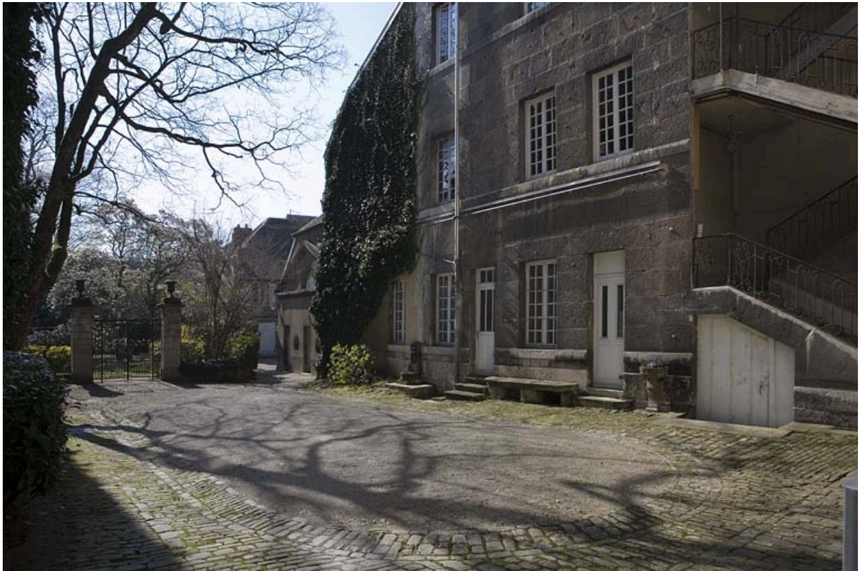
Vue d'ensemble de l'aile sur cour.
