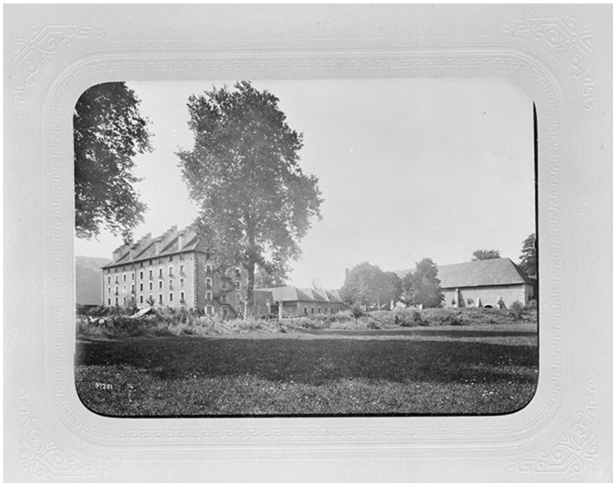
Usine de Buillon, 1899-1900.
