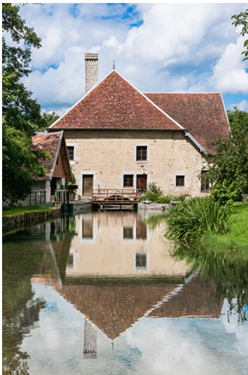
Vue d'ensemble depuis l'amont (cadre vertical).
