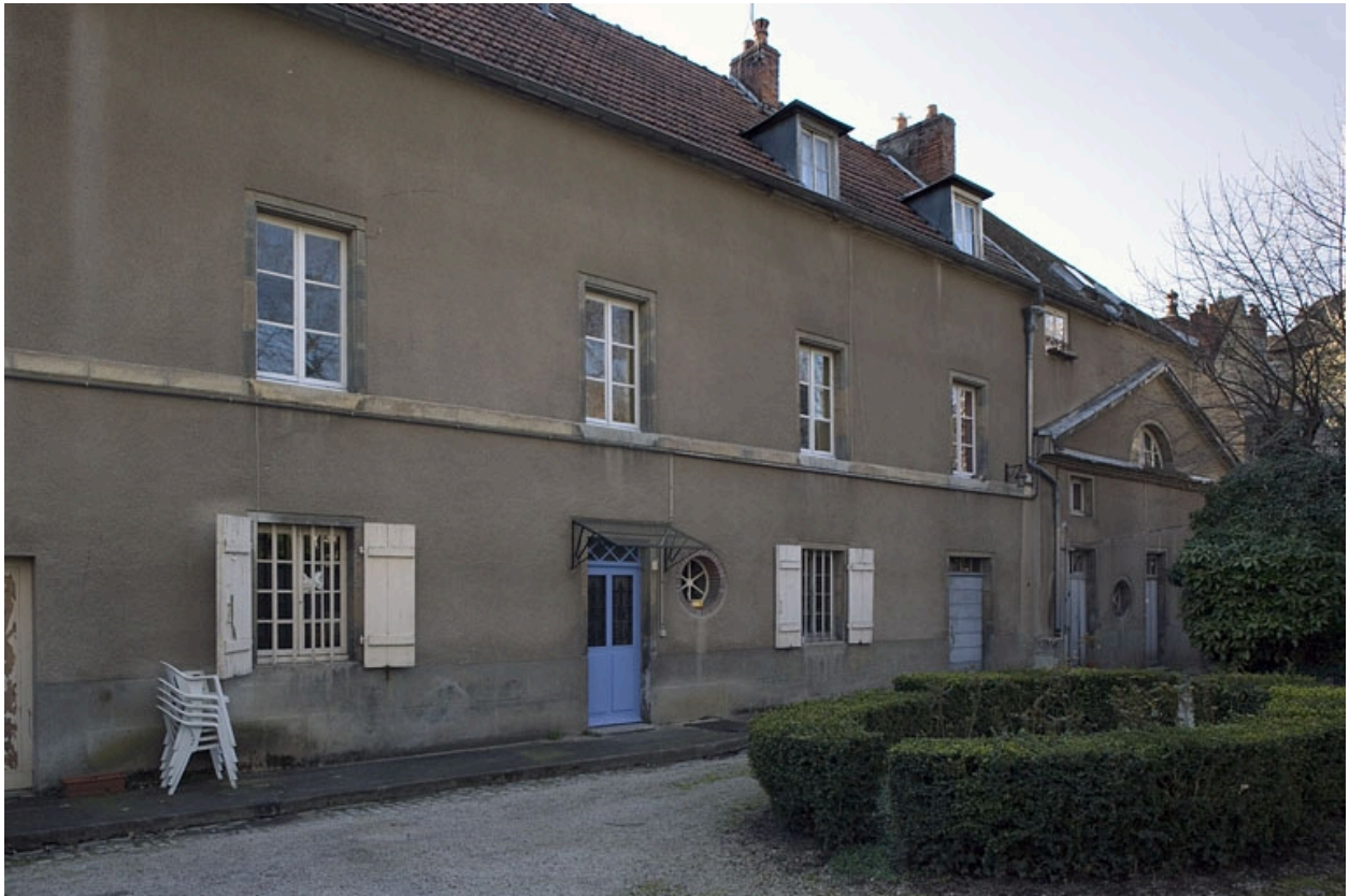
Vue d'ensemble du logis au fond de la deuxième cour.
