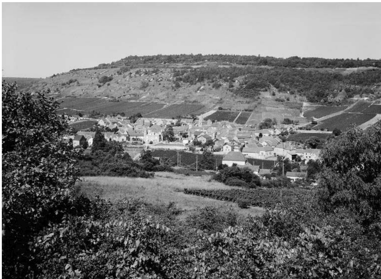
Vue générale de Saint-Aubin.
