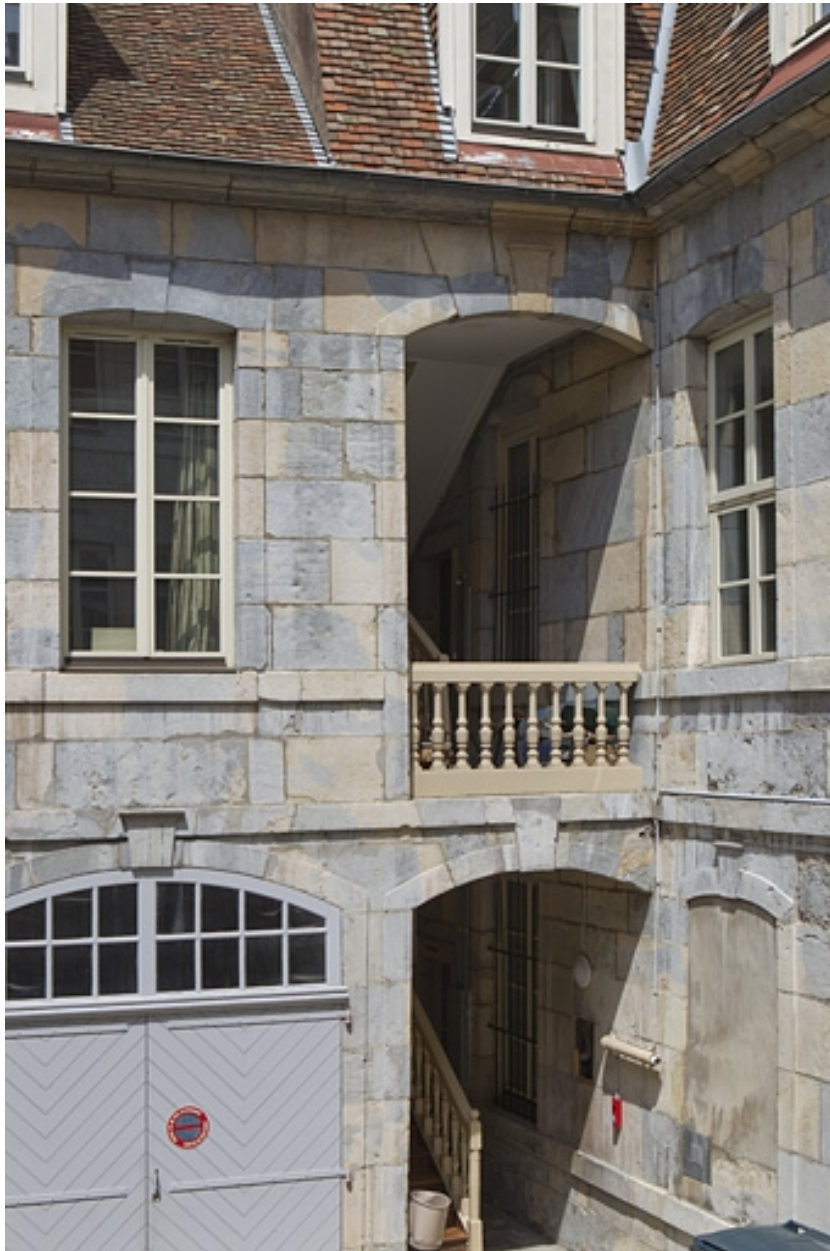
Détail de l'escalier à cage ouverte droit depuis celui de gauche.
