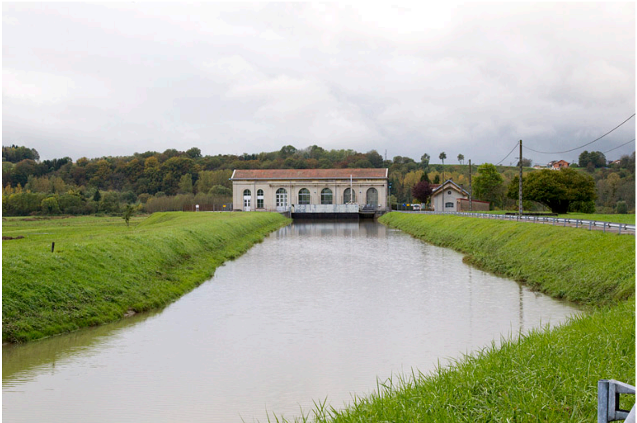
La centrale depuis le bief d'amenée.
