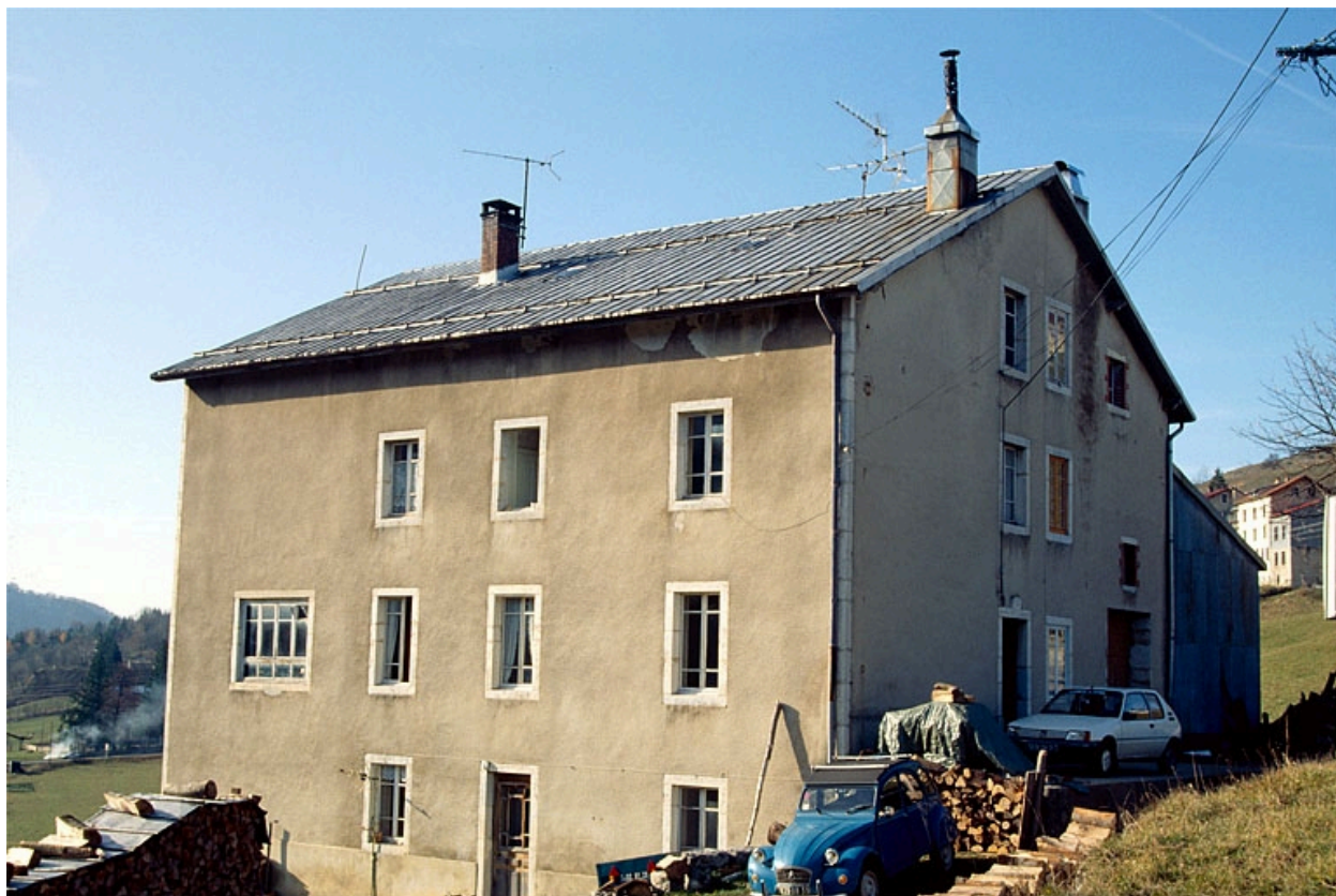
Façades antérieure et latérale gauche.
